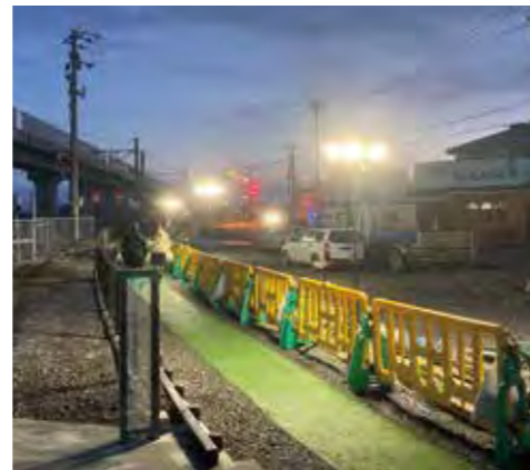
夜間の現場でも明るく照らすことができます。
