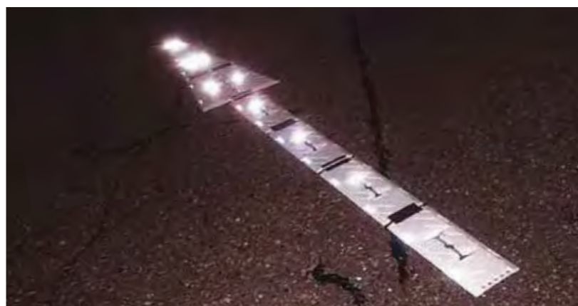
施工イメージ(実績写真) 矢印板との並行利用で車線絞り込みが可能です。
